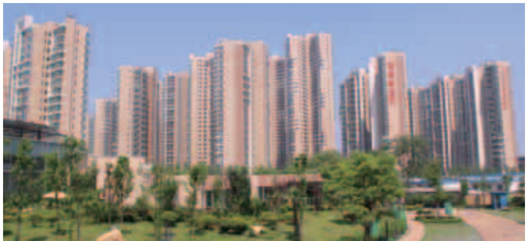
長沙新城新世界一期主要由高層住宅所組成
